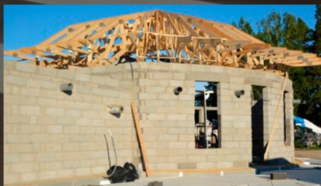
Monteringsrören på plats
